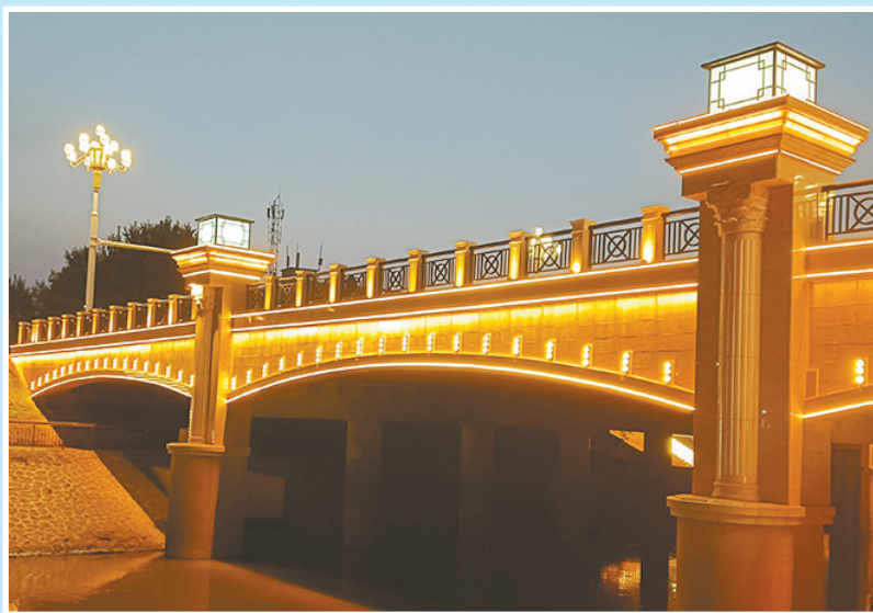
新建设桥夜景
