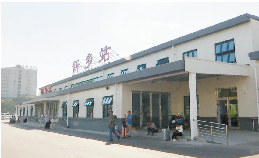
新建过渡站房
