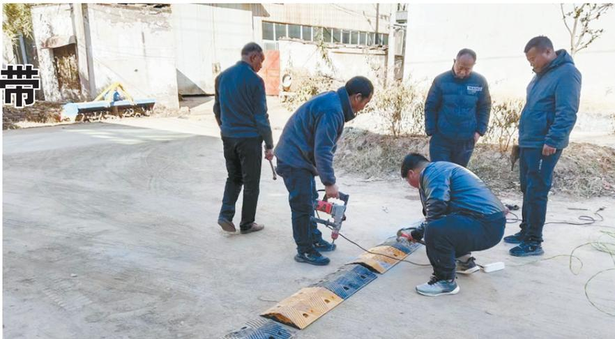
施工人员正在村内安装减速带
