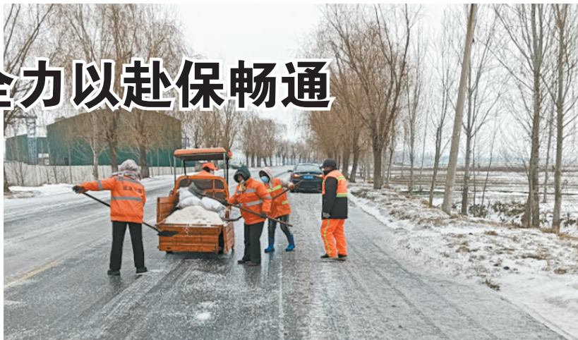
清雪除冰现场
