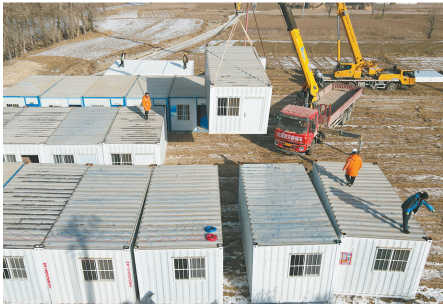
12月21日,在积石山县大河家镇梅坡村,施工人员进行搭建活动板房(无人机照片)。
