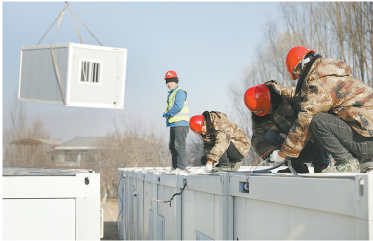
12月24日，在积石山县刘集乡陶家村一集中安置点，施工人员给活动板房接通电源。 新华社记者 方欣 摄
