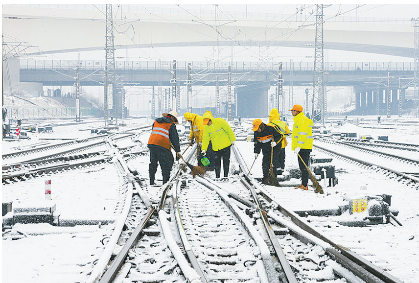
2月4日,合肥东站工作人员在清除道岔积雪。近日,安徽多地迎来雨雪天气,气温大幅下降,给交通运输和群众生产生活带来影响。 新华社发
