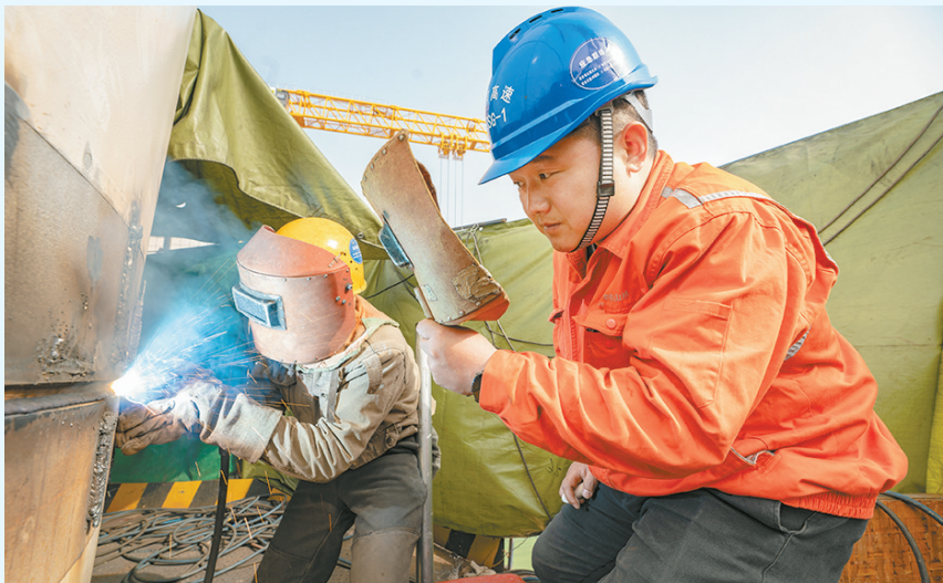
我市在建高速项目施工现场
