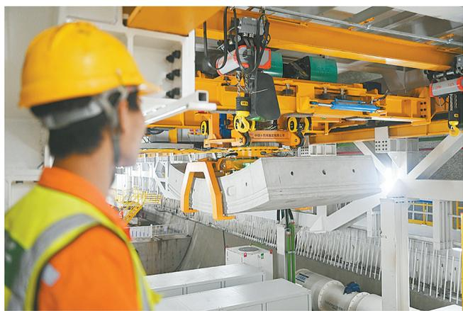
5月16日,中铁十四局技术人员在甬舟铁路金塘海底隧道内操作管片吊装设备。
