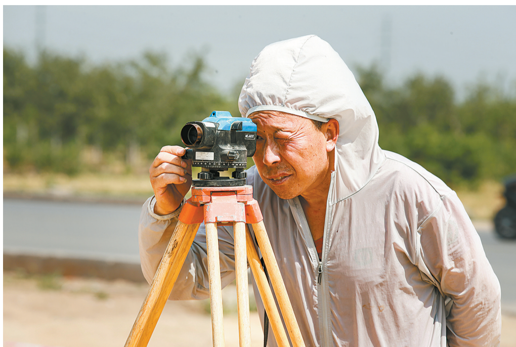
顶着烈日测绘的筑路工人
