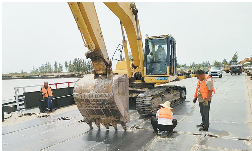
浮桥拆除施工现场
