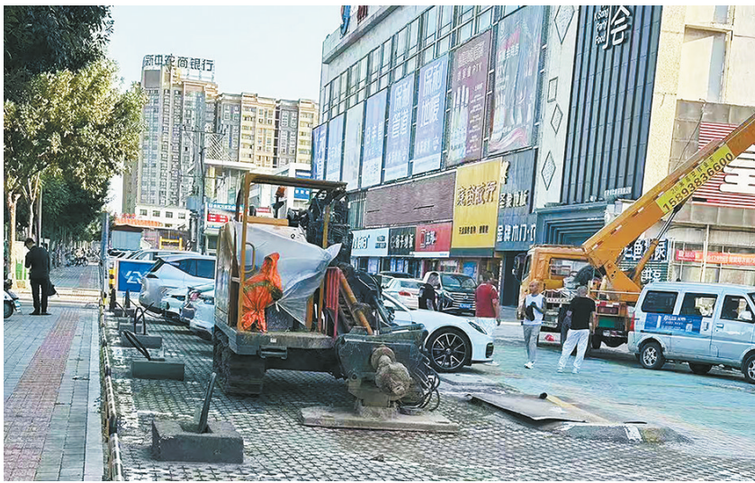
建设中的充电桩
