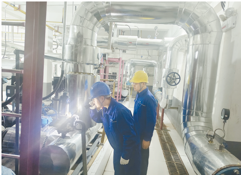
工作人员检查小区热力交换站
