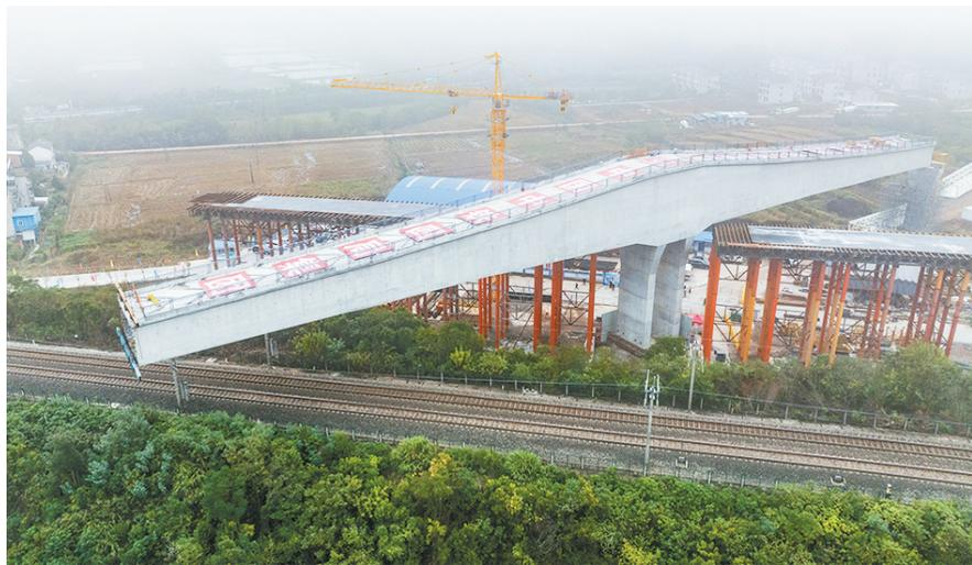
10月23日拍摄的湖北蕲春长胶廊道跨京九铁路连续梁转体作业现场（无人机照片）。
