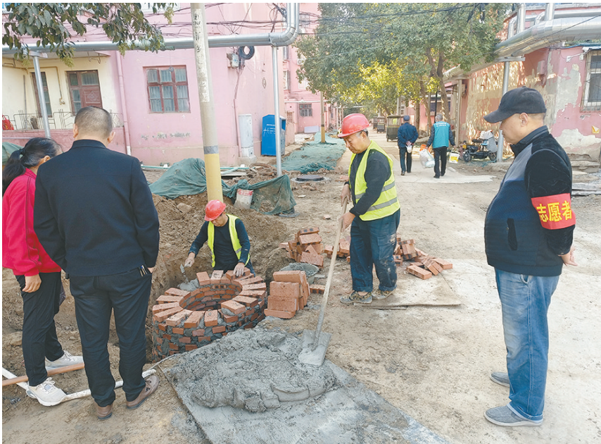
540厂家属院改造施工现场
