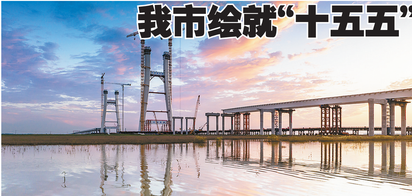
我市重点高速项目施工现场
