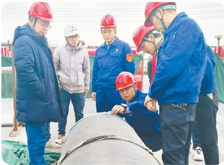
华电热力领导班子到施工现场进行检查
