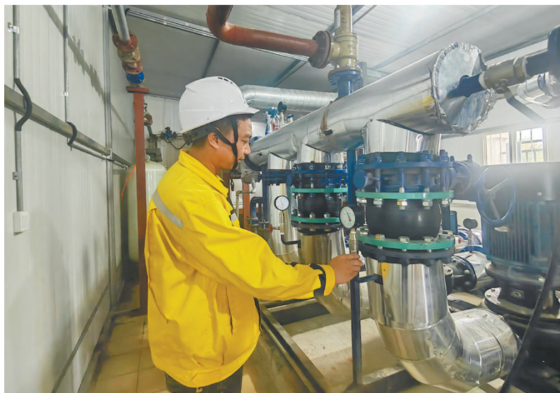
检查供热设施
