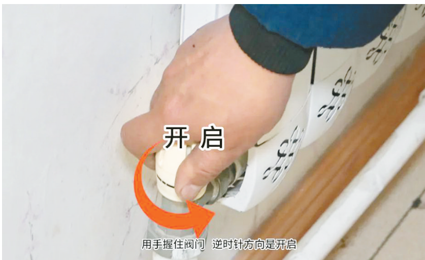
开关室内暖气阀门示意图
