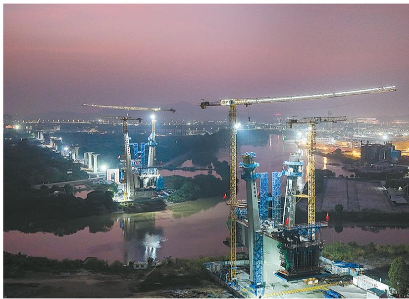
广佛西环线广州炭步白坭河特大桥主墩双索塔浇筑施工现场(12月10日摄,无人机照片)。
