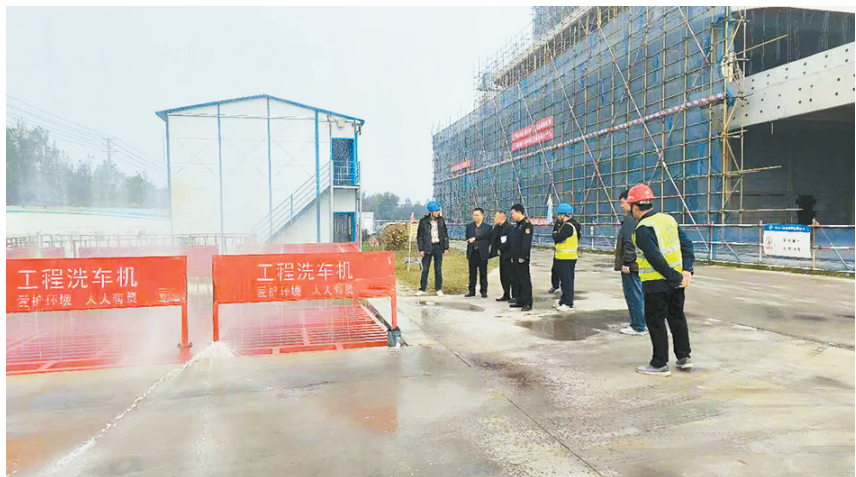
执法人员检查工地内进出口清洗设施
