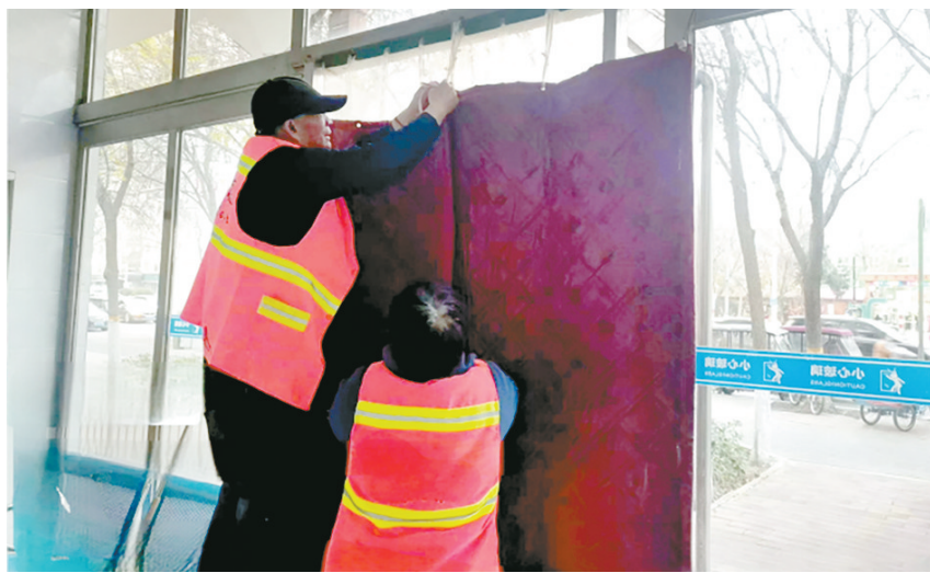
工作人员正在为公厕安装棉门帘
