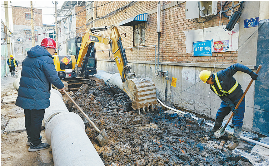
雨污水分流改造工程施工现场
