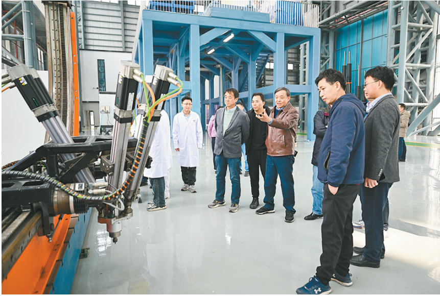
3月9日，专家组对聚变堆主机关键系统综合研究设施八分之一真空室及总体安装系统进行测试和验收。 新华社记者 周牧 摄
