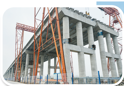
▲兰原高速兰考至封丘段 黄河大桥施工现场
