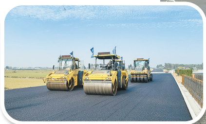
▲安罗高速施工现场
