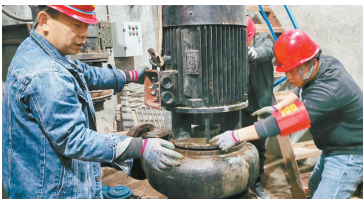
市政工人对水泵进行检修
