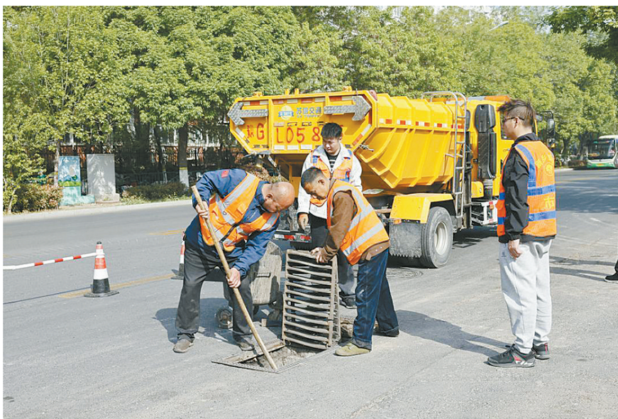
清淤疏浚现场
