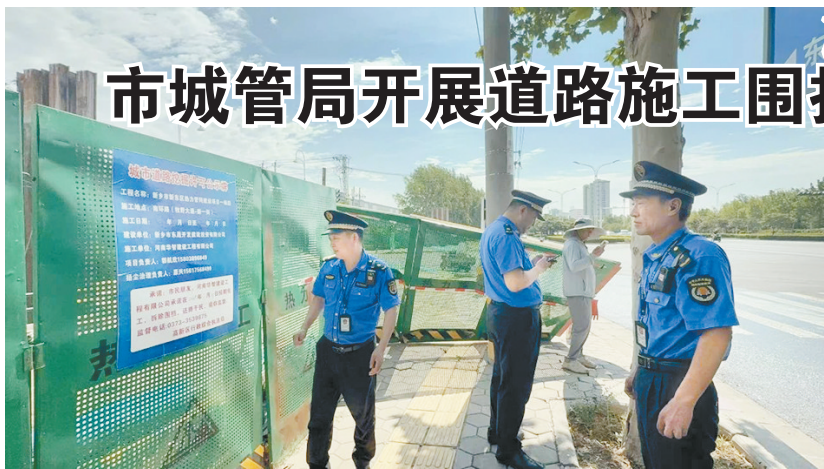
执法人员对某热力工程围挡进行检查
