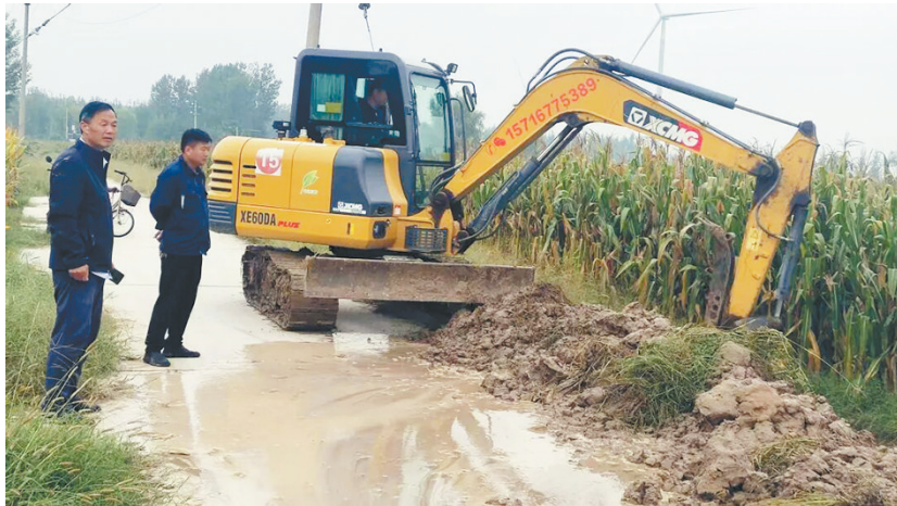
挖掘机进行排水作业
